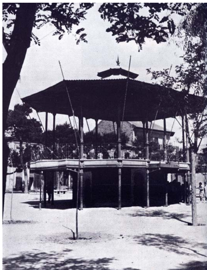
Figura 15. Fotografía del Templete de música que se mantuvo durante cincuenta y cuatro años como centro de la plaza de Benalúa (1911-1965). Autor desconocido.
