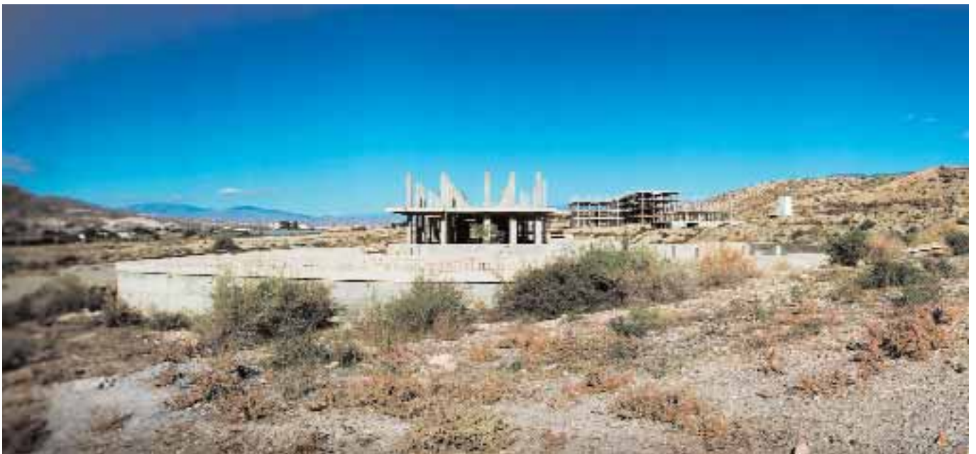
Estructuras visibles 05. Viator, Almería.
