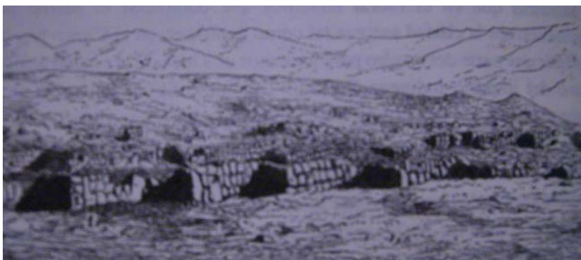
Muros ciclópeos de Sacsaihuaman.
