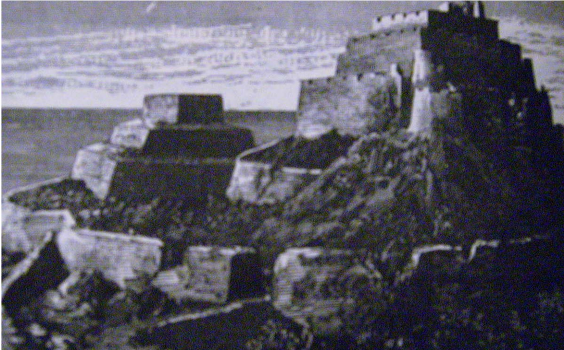
La fortaleza de Paramonga desde lo alto de los últimos contrafuertes de la cadena marítima (WIENER, 1880: 122).
