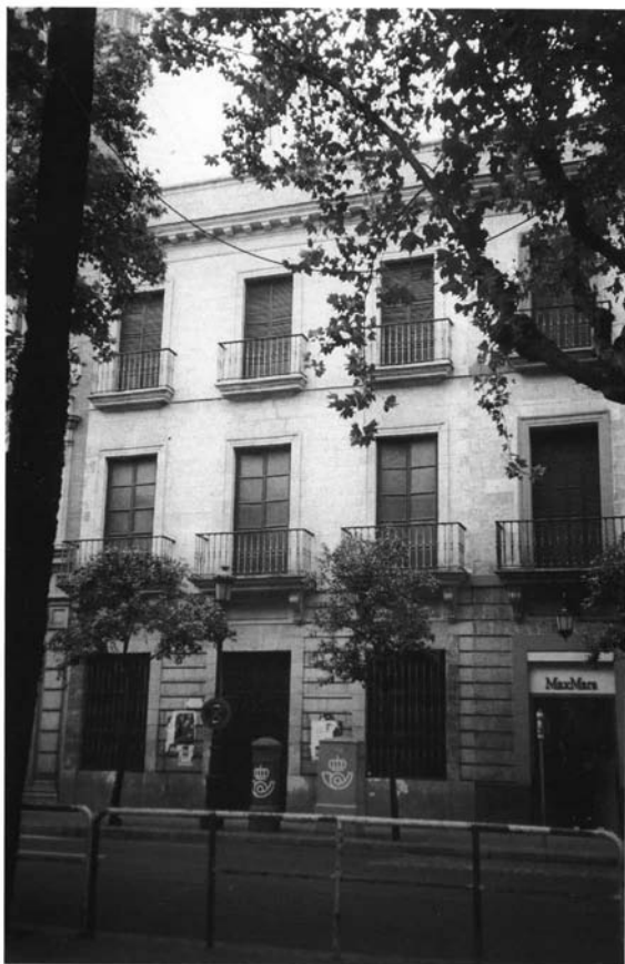
Estado actual de la fachada de la Capilla de San Onofre de Sevilla (fotografía: Autor)
