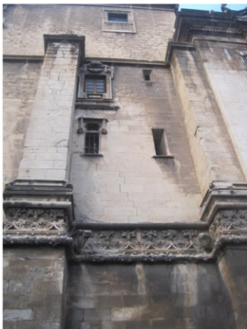
Figura 3. Elementos góticos en el muro oriental.
