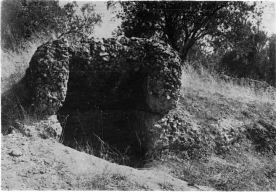
5) Abertura para iluminación y ventilación del criptopórtico de Carchena.
