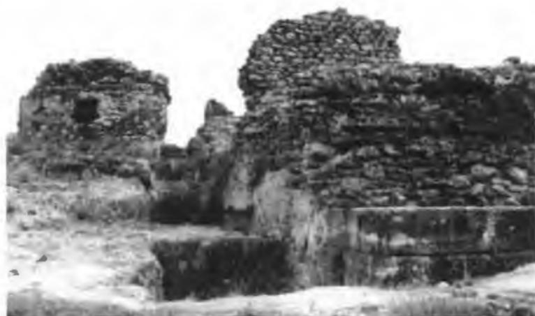
FIG. 1. Fotografía en la que se puede observar a la derecha los bloques utilizados para revestir los Trofeos de Pompeyo, así como en la parte central las hileras despojadas de sus correspondientes sillares.
