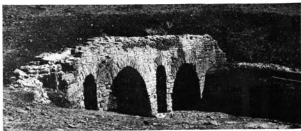
Fig. 7.—Acueducto sobre el arroyo de la Chorrera.
