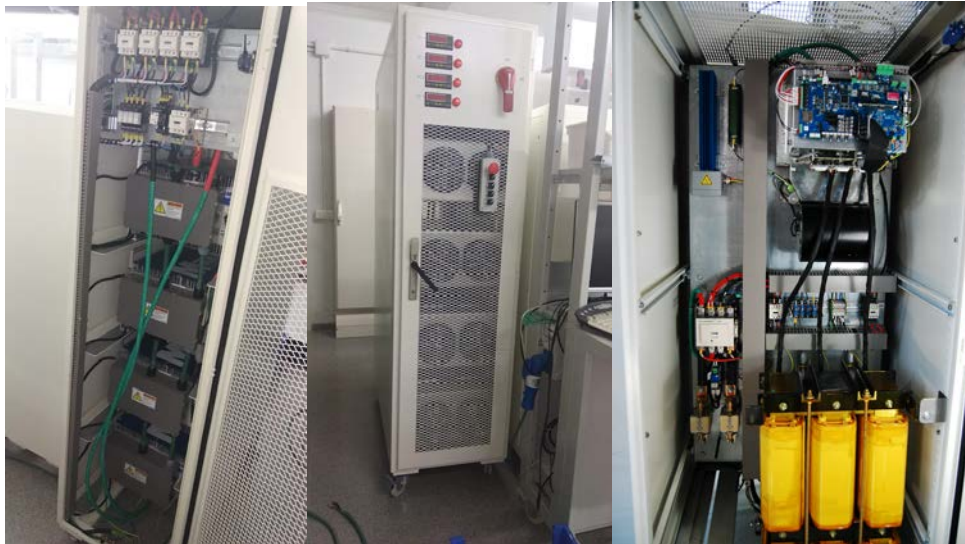
Banco de supercondensadores 50kW y convertidor de DC-DC que procesa su potencia
