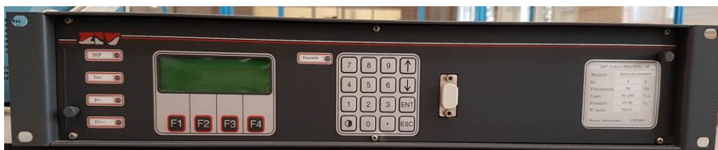
Figura 33. Protección de distancia ZLS Distance.
