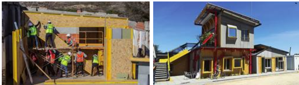
Fig 4. Contraposición del proceso de construcción comunitaria (noviembre 2018-marzo 2019) y la edificación, en la cual observamos la reutilización de estructuras y materiales, como las ventanas, de perfiles dispares. Recetas Urbanas.
