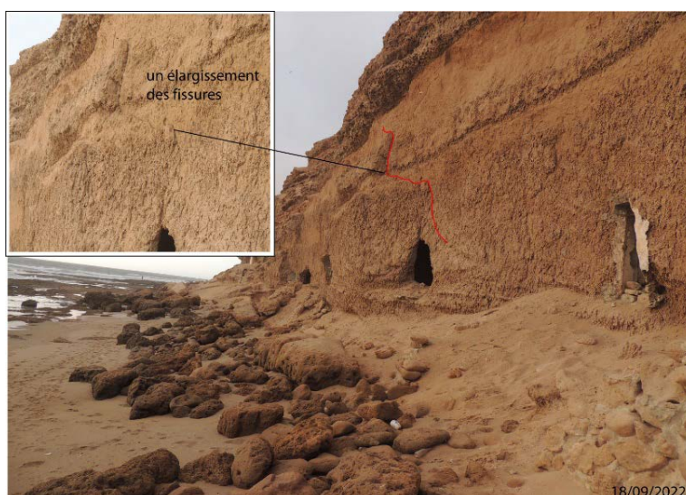
Figure 15. Elargissement des fissures au niveau des parois des falaises. Source : clichés personnels.
