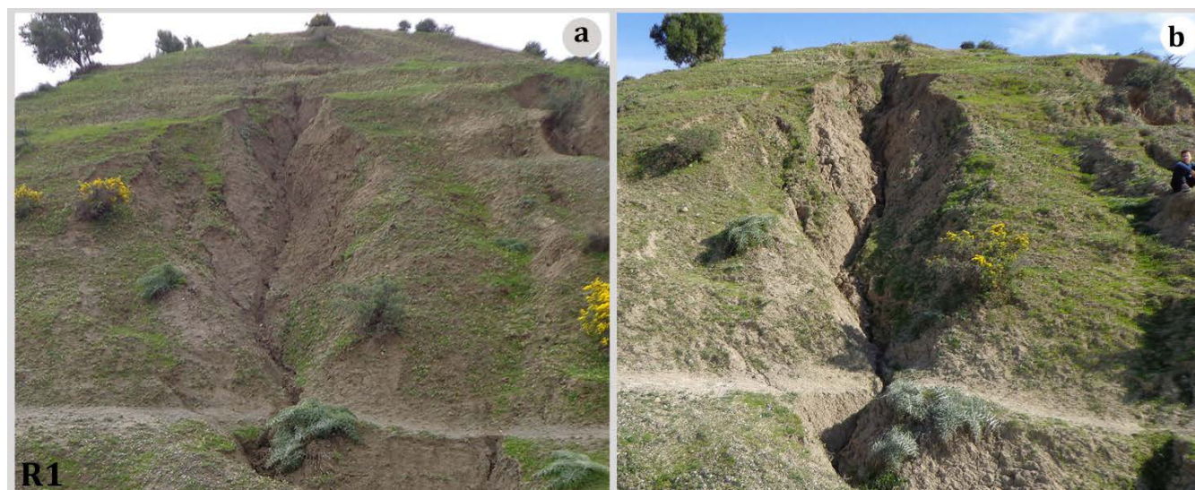
Figure 11. Dynamique du ravin R1 par affouillement des berges. a). État du ravin en 2018. b). État du ravin en 2021. Source : propre élaboration.
