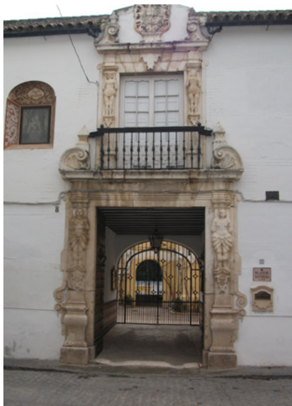
(Fig. 5. Fachada del palacio de Santaella)
