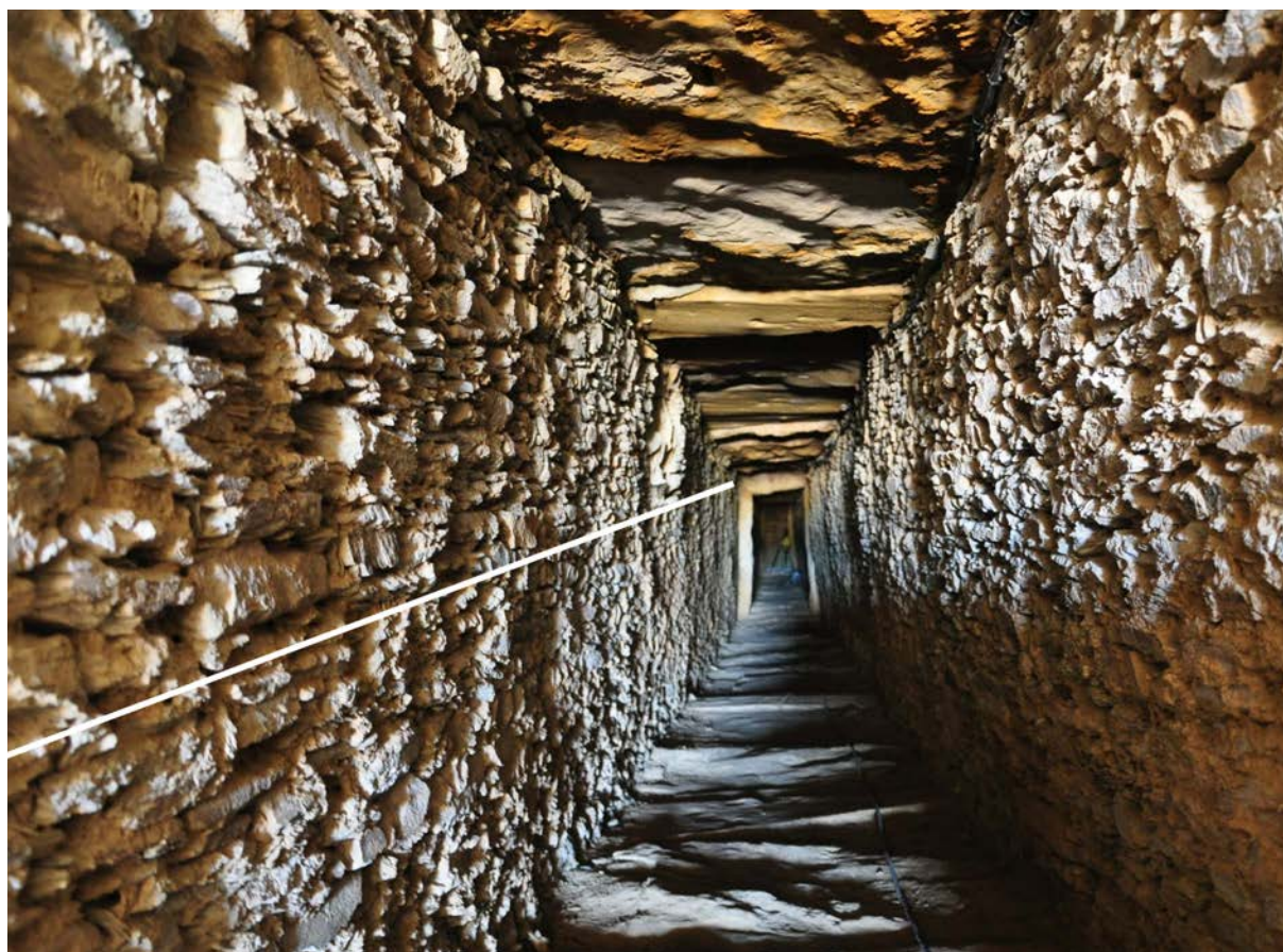
Figura 9. Interior del corredor con alineación oblicua de mampuestos dispuestos como refuerzo estructural.
